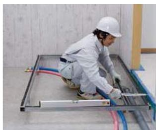
給水・給湯配管の接続や床のレベル調整が内側からできます。
